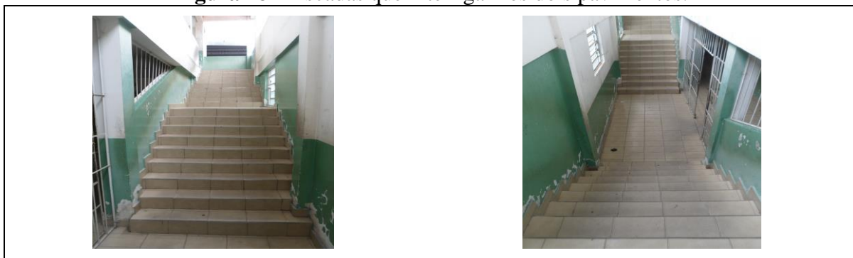
Figura 18 – Escadas que interligam os dois pavimentos.
