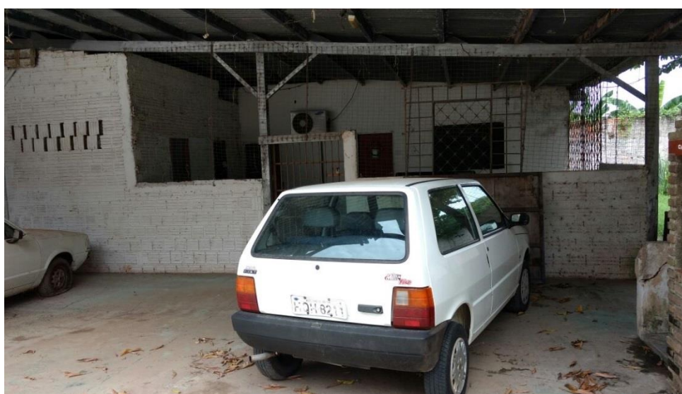
Figura 07: Área externa do espaço destinado à educação escolar do EPRSAAAC. Fonte: Arquivo da Assessoria de Imprensa - AGEPEN. Disponibilizado ao pesquisador em janeiro de 2017.
