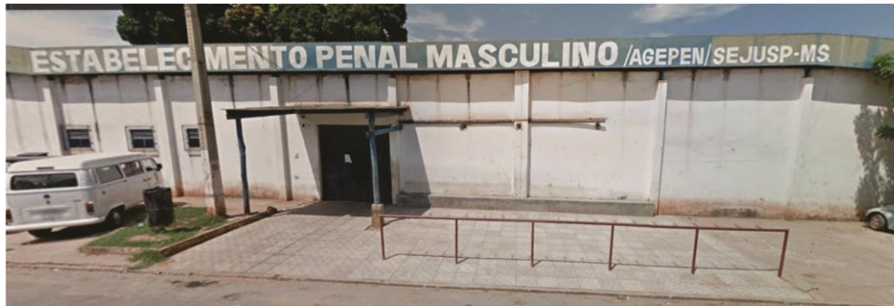
Figura 19: Vista frontal externa do EPC.
