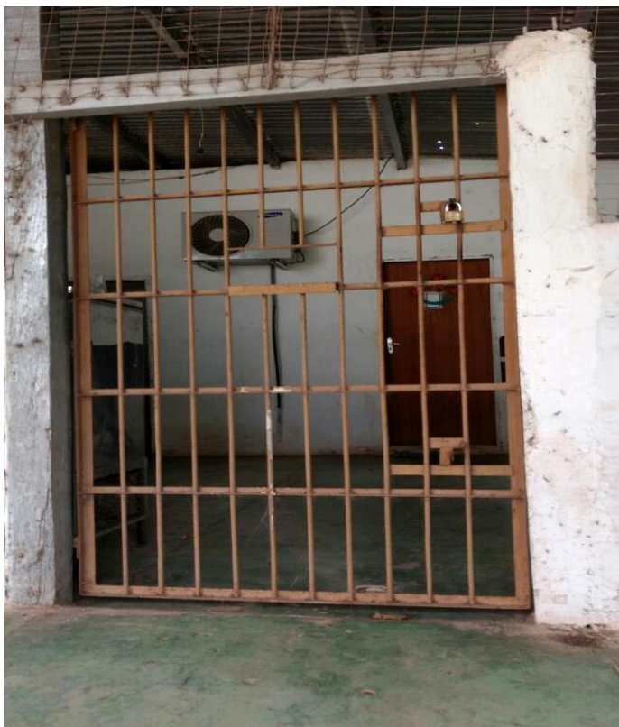
Figura 08: Entrada da área externa das salas de aula do EPRSAAAC.
